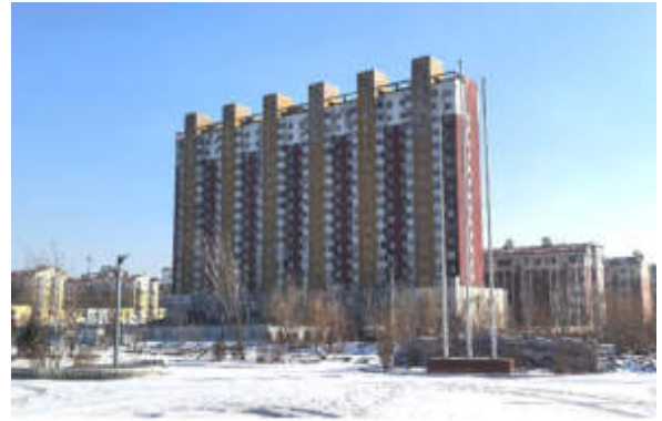
医院南侧（解放花园小区）
